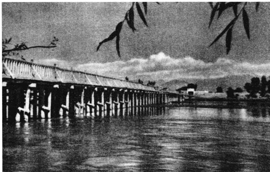
横跨开都河的九十余孔的大桥
