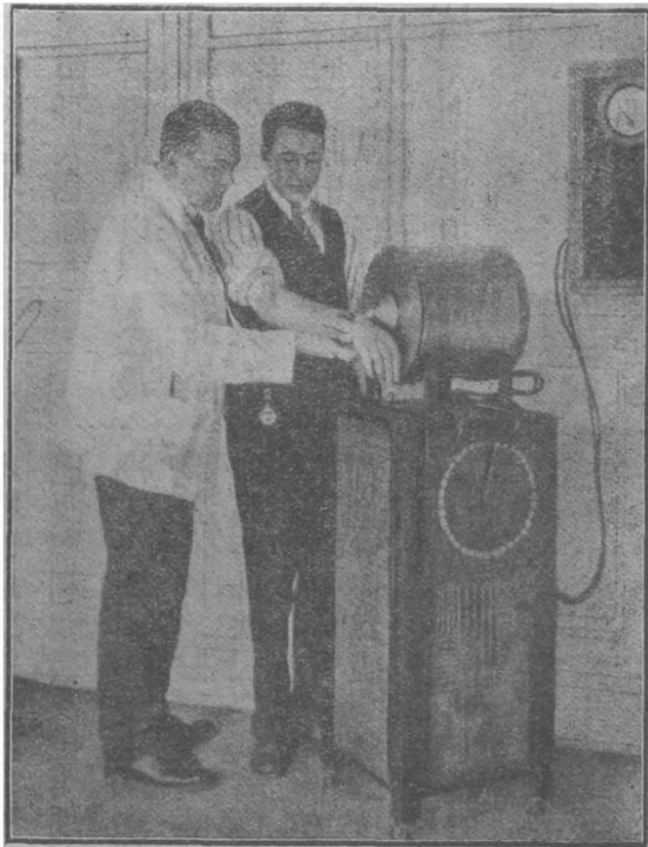
受傷兵卒肌肉內有鋼鐵屑等藉電磁移去之
