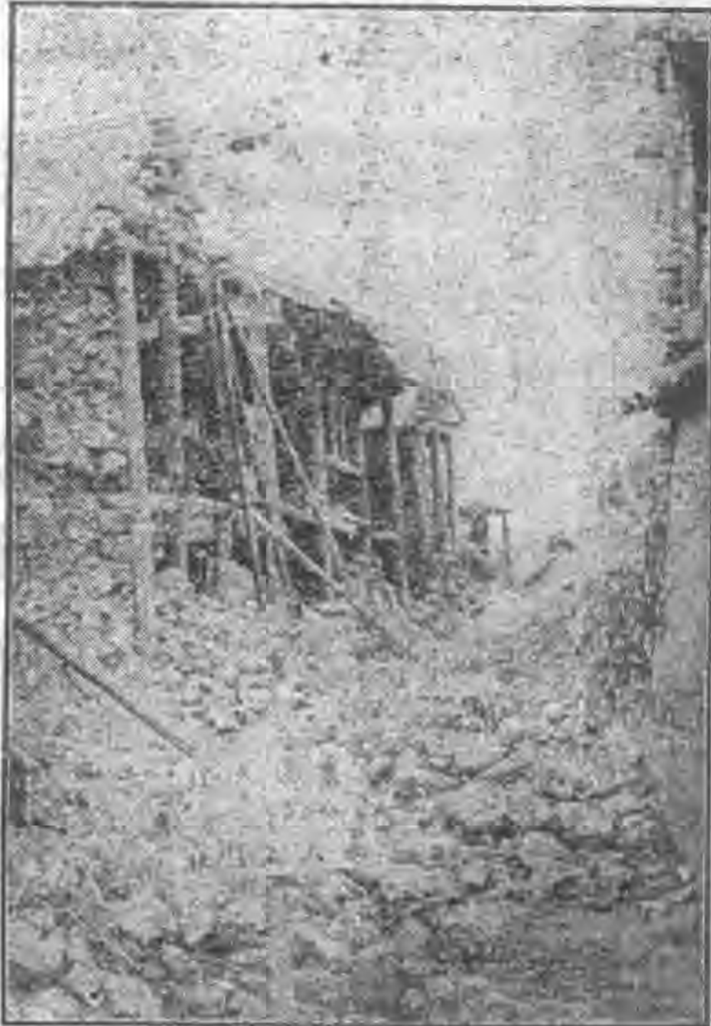
大理白塔邑房屋之倒塌
