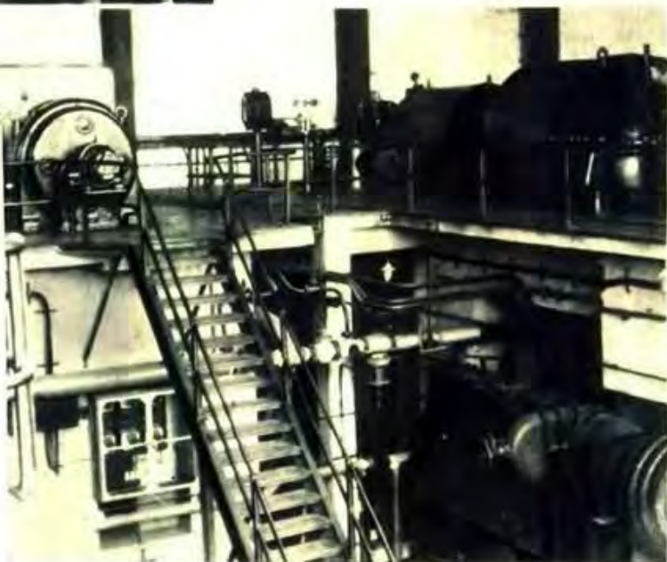
↑ 透 平 發 電 機 間。
