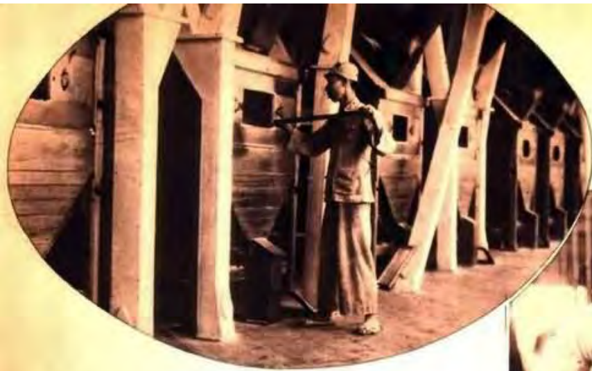
→磨成的粉，經過方篩的篩折，分為頭、二、三、四種的粉質。 個較次的三四號粉，由方篩轉入圓篩，篩淨，其不能成爲粉的麥皮即轉入麥皮機。
