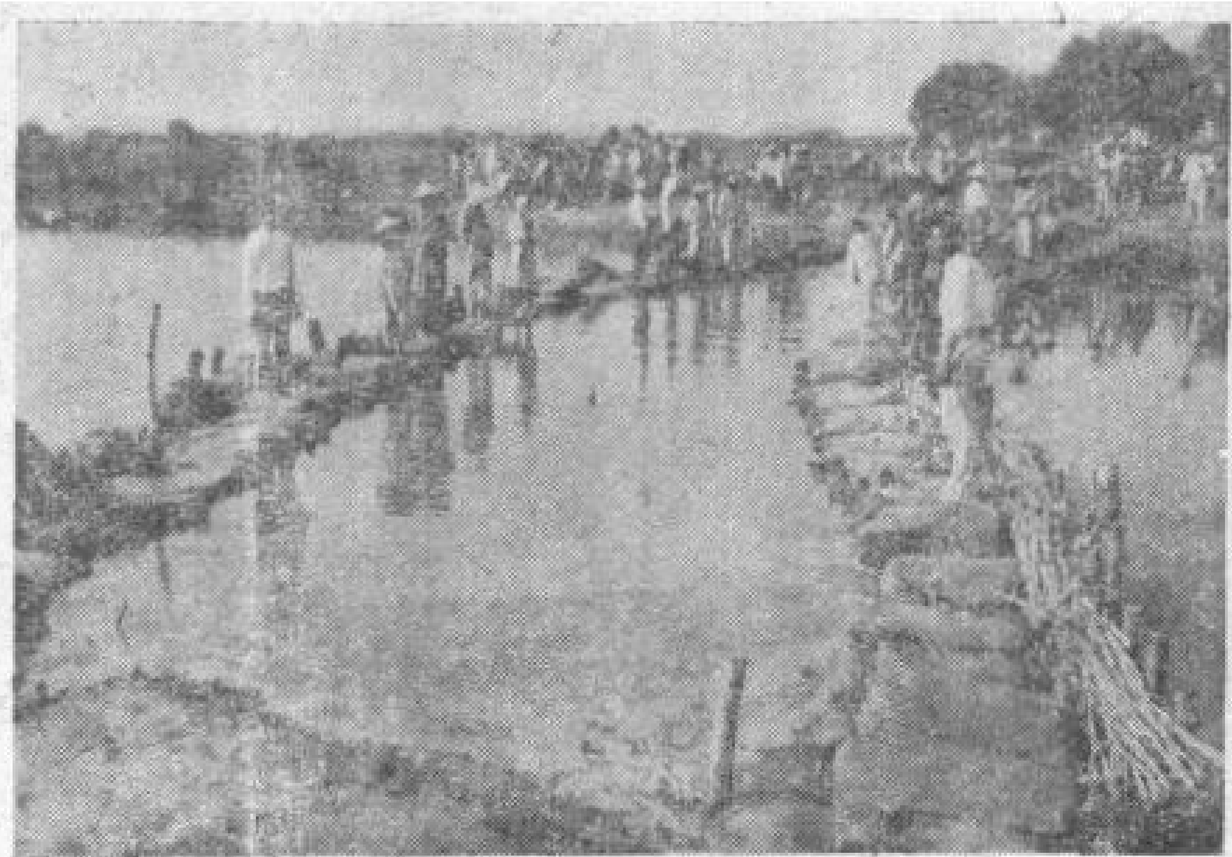
(四圖) 荆山縣荆山橋決口後修堵情形
