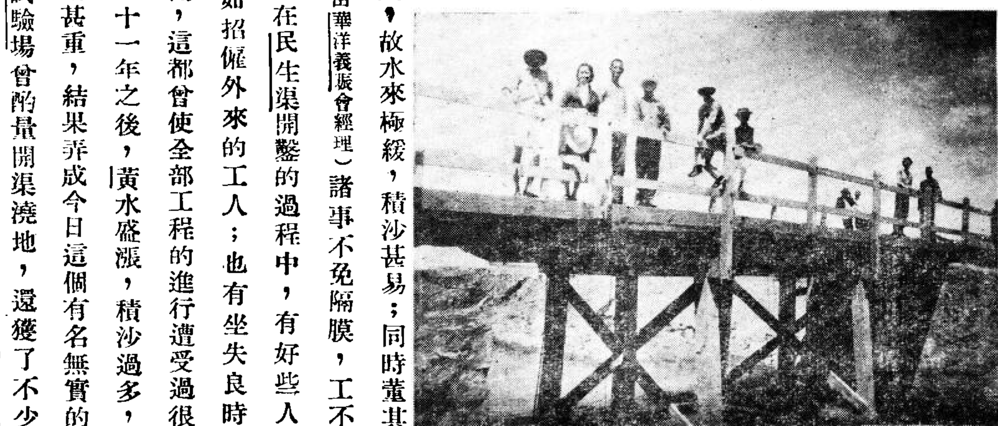
民生渠木橋上留影
