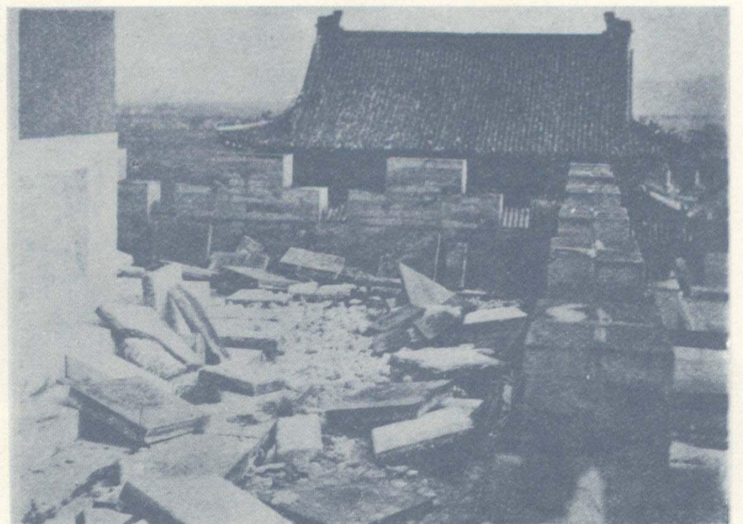
部 一 之 後 毀 被 上 台 樓 墓 陵 后 太 西 Showing the spot of excavation
