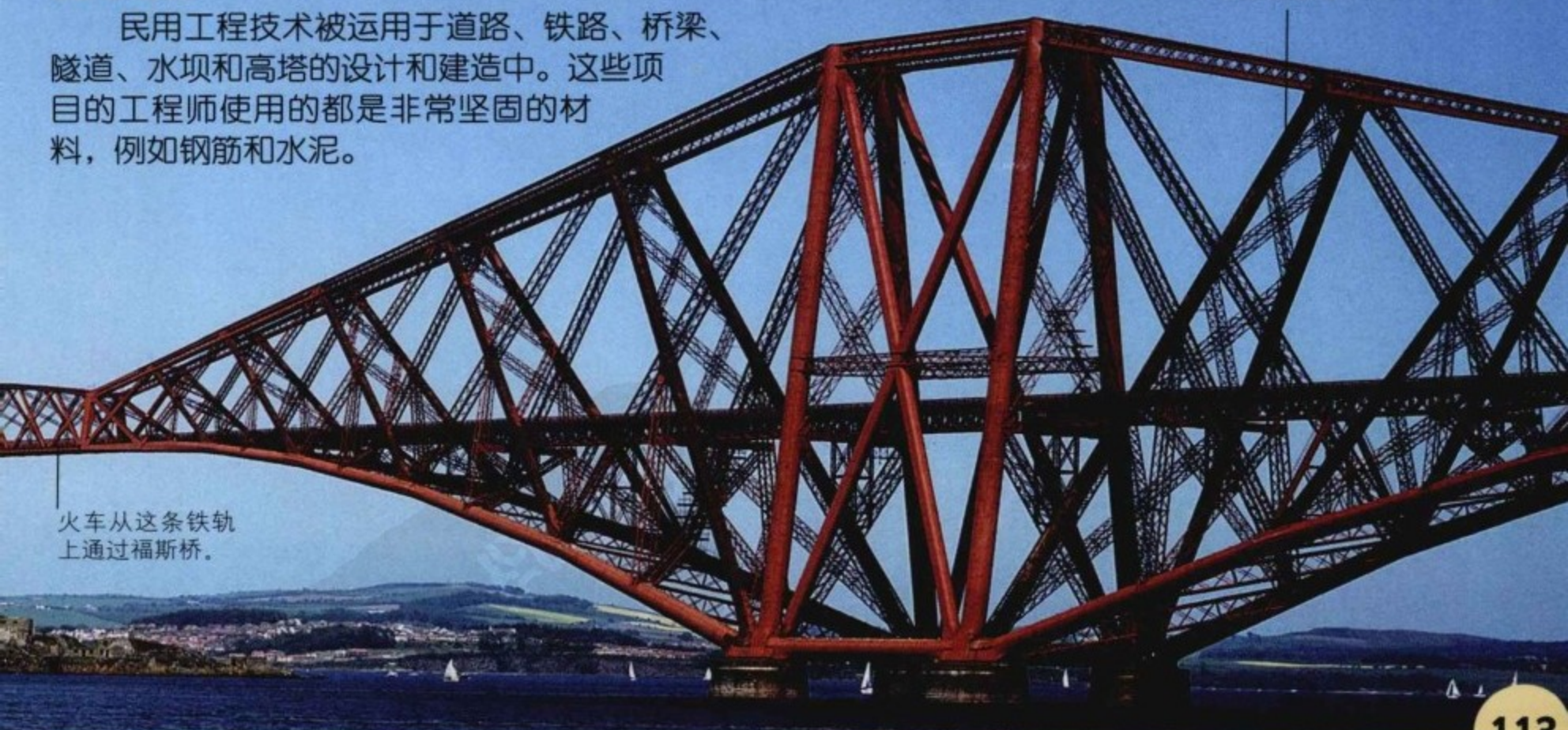
这座桥由很多巨大的钢管组成。
