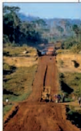
Unpaved section of the Transamazônica
