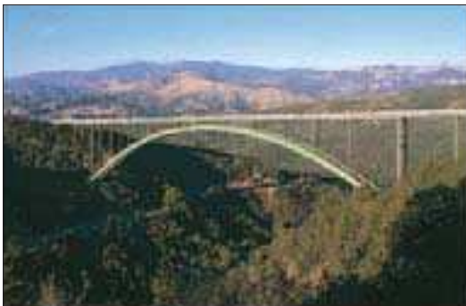
Cold Spring Arch Bridge, Los Padres National Forest
