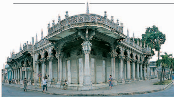
The unusual façade of the Palacio de Guasch, Pinar del Río
