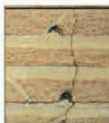
Compressed cob: pisé
