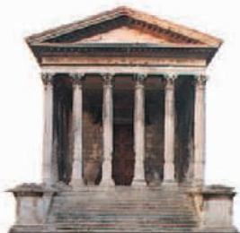
The Maison Carrée
