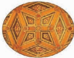
Gilded ceiling, Château de La Palisse
