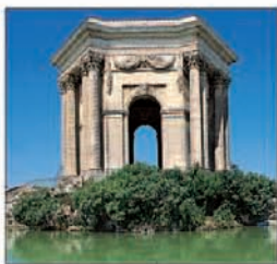
Château d'Eau, Montpellier
