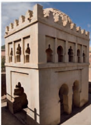
Exterior of Koubba El Badiyin
