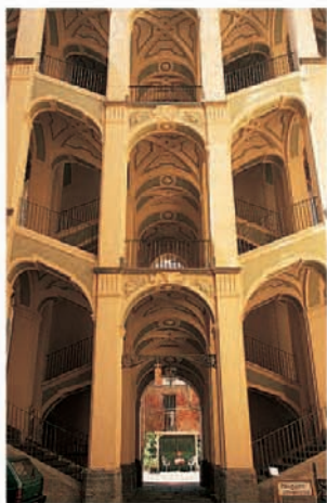
Staircase, Palazzo dello Spagnolo
