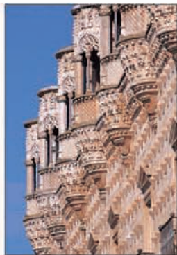
Detail of the façade of the Palacio de los Duques del Infantado
