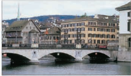
The Münsterbrücke, spanning the Limmat in Zürich
