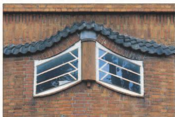
Detail of a set of windows on the Zaanstraat
