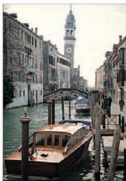
Distant view of San Giorgio dei Greci's tilting campanile
