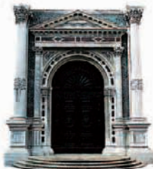
Restored main entrance to the Scuola di San Rocco
