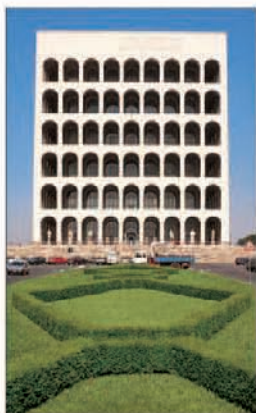
EUR's Palazzo della Civiltà del Lavoro, the “Square Colosseum”
