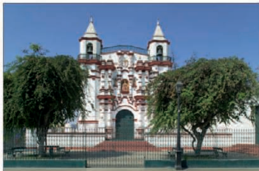
Imposing façade of the Iglesia y Monasterio del Carmen
