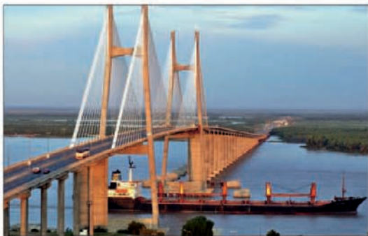
The majestic Puente Rosario-Victoria bridge over Río Paraná
