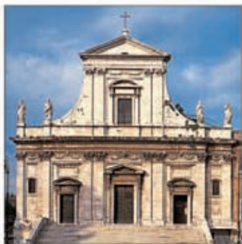
Facade of Santa Maria della Consolazione
